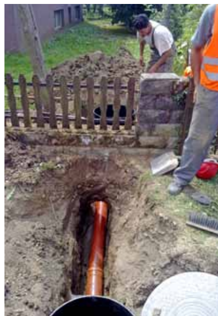
A szennyvízcsatorna építése • Izgradnja kanalizacije
