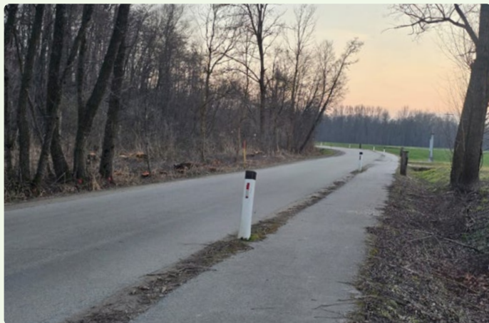
Slika 40: Kolesarska steza ob občinski cesti JP 707121 HOTIZA-MURIŠČE
