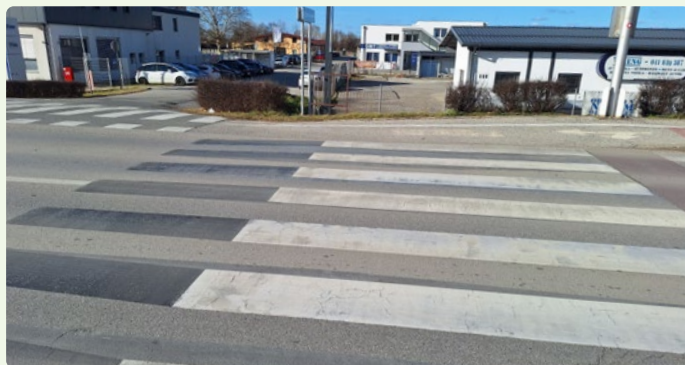
Slika 6: 3D prehod za pešce na občinski zbirni cesti LZ-206501-0048 Kolodvorska ul. – Glavna ul. – učinkovit ukrep za umirjanje prometa in povečanje varnosti pešcev. Zaradi optične iluzije vozniki intuitivno zmanjšajo hitrost, kar je posebej pomembno na občinskih zbirnih cestah z večjo prisotnostjo ranljivih udeležencev v prometu.
