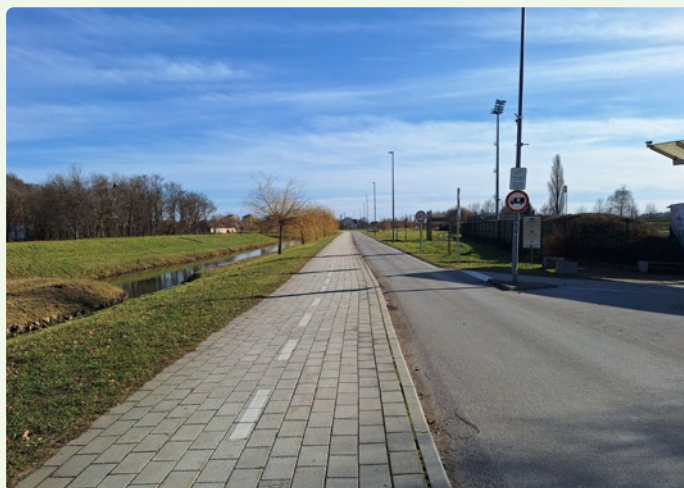
Slika 27: Denivelirana kolesarska steza ob lokalni cesti JP707391 na Kolodvorski ulici v Lendavi pomeni kakovostno prometno rešitev, ki jasno ločuje kolesarski promet od motornega. Z višinsko razliko med voziščem in kolesarsko stezo se povečuje varnost kolesarjev
