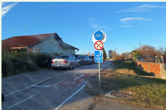
Slika 33: Dvosmerna asfaltna kolesarska steza na relaciji Dolga vas-Lendava je celovito urejena in fizično ločena od Glavne ulice, kjer poteka motorni promet. Takšna ureditev bistveno povečuje varnost kolesarjev, omogoča nemoteno kolesarsko povezavo med naseljema ter spodbuja uporabo kolesa kot vsakodnevnega prevoznega sredstva
