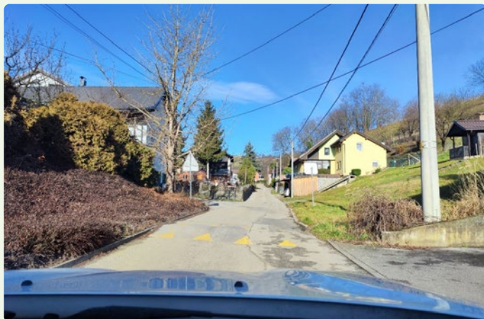
Slika 66: Grbina za umirjanje prometa na lokalni cesti LC 206201 Lendava-Lendavske Gorice
