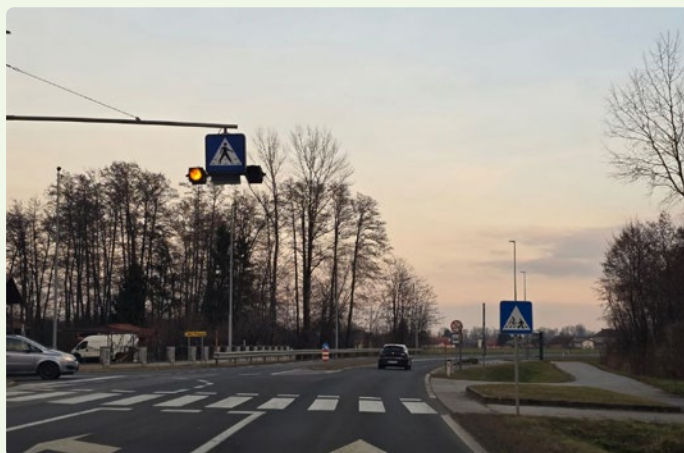
Slika 39: Kolesarska javna pot KJ 970611 se na odseku Grede-Hotiza nadaljuje preko regionalne ceste R2-443/0322 Črenšovci-Dolnji Lakoš z urejenim prehodom za kolesarje. Prometna ureditev omogoča varno prečkanje državne ceste
