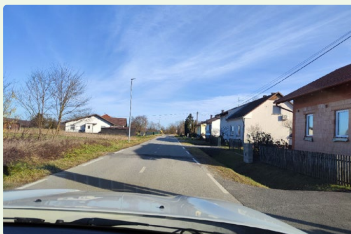
Slika 65: Na lokalni cesti LC 206011 Pince-Petišovci v naselju Benica ni urejenih pločnikov niti posebej označenih površin za kolesarje, zaradi česar morajo vsi udeleženci v prometu uporabljati isto vozišče. Ta prometna ureditev povečuje tveganje za konflikte motoristi, kolesarji in pešci ter zahteva dodatne ukrepe za izboljšanje prometne varnosti in kakovosti prometnega prostora
