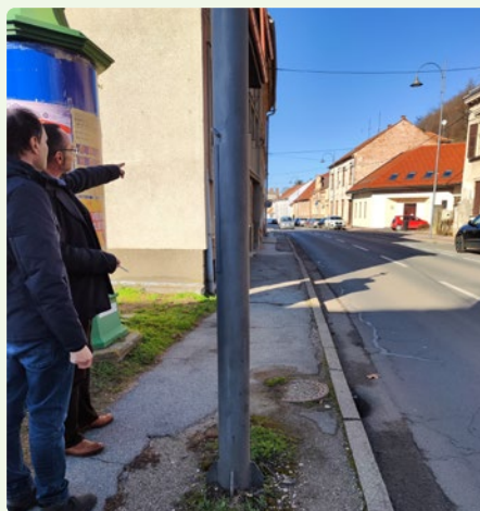
Slika 18: Kandelaber na sredini hodnika za pešce predstavlja prostorsko oviro in zmanjšuje pretočnost ter varnost za ranljive skupine, zlasti za osebe z zmanjšano mobilnostjo. Dodatno je obrabljena asfaltna plast deniveliranega pločnika znak dotrajanosti, zato je smiselna celovita sanacija površine in prestavitev ovir zunaj glavne peš poti
